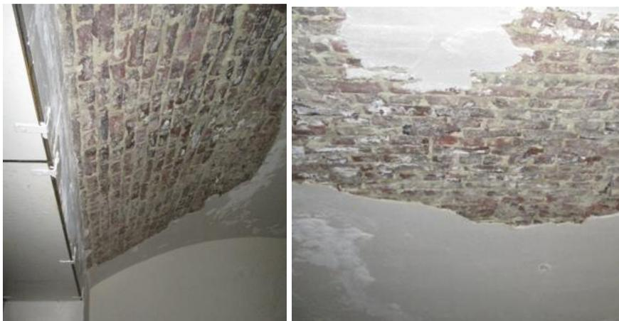
*[Une cellule (4-personnes) condamnée à l'annexe psychiatrique : le plafonnage du plafond s'est écroulé, l'humidité est omniprésente, tentatives de réparation infructueuses et à l'arrêt pour l'instant (le problème est structurel : l'humidité persiste)]*
