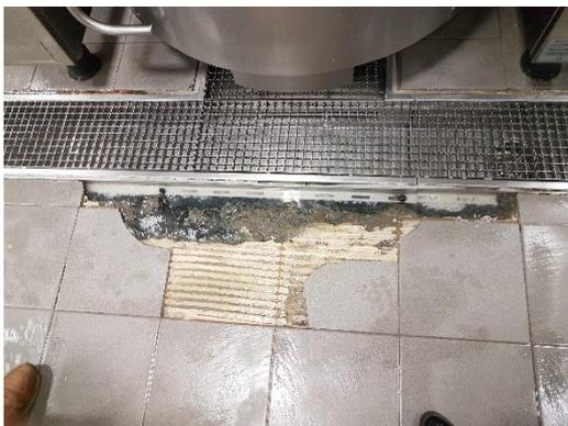
*La cuisine, récente et bien équipée, souffre déjà de dégradations, dues sans doute à une mauvaise pose du carrelage et des joints. La réparation se fait attendre. Cette situation présente des problèmes de sécurité (chutes) et des risques de développements bactériens*
