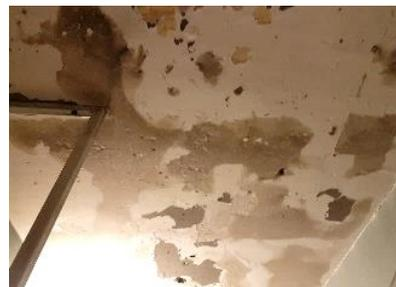
L'humidité suinte, la dalle de béton se désagrège, juste sous l'emplacement du WC de la cellule de l'étage supérieur.
