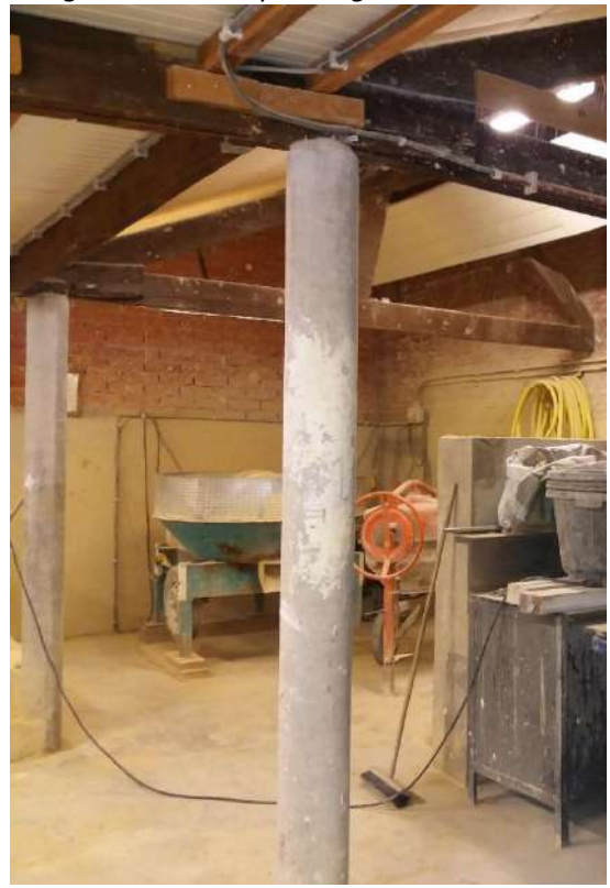
Hoogstraten – Opleidingscentrum VDAB
