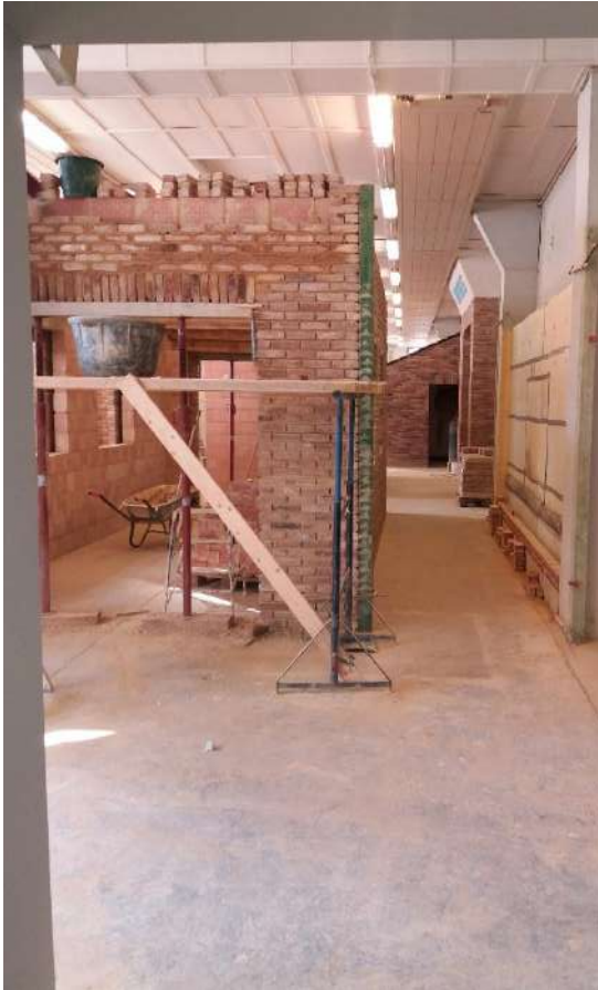
Hoogstraten – Opleidingscentrum VDAB
