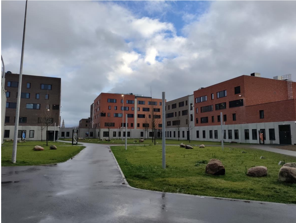
Figure 15 Place centrale, vue sur la Ocean House et la Mountain House.
