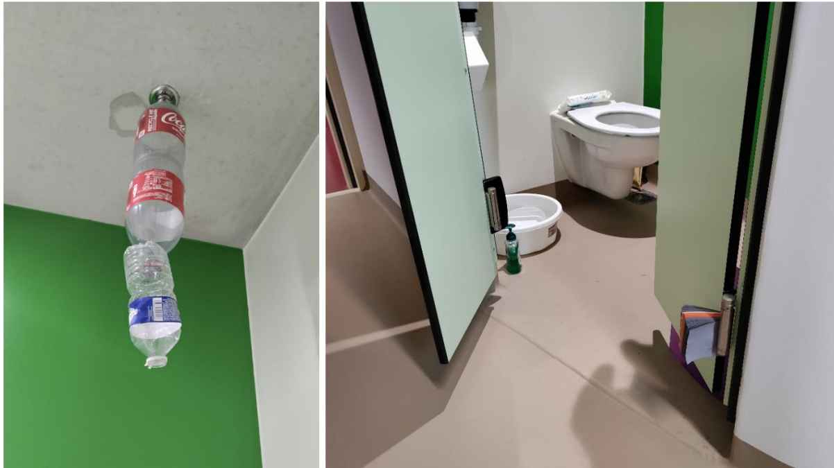
Figure 28 Système pour concentrer le jet de douche et du système pour “coincer les portes”
